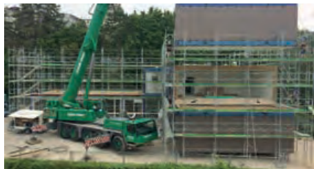
29.06.16 – les modules de bout ont déjà le revêtement extérieur
