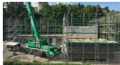
28.06.16 – le premier niveau est assemblé
