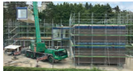
30.06.16 – les derniers modules, posés en porte-à-faux, sont soulevés
