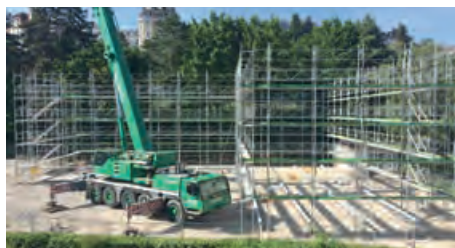
27.06.16 – le chantier est prêt pour les 3 jours de montage
