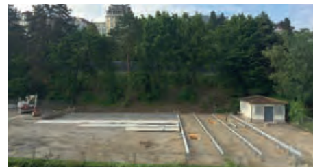
juin 2016 – fondations sous forme de vis réutilisables
