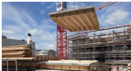
Dalles mixtes préfabriquées, Microcity, Neuchâtel Photo: Yves André
