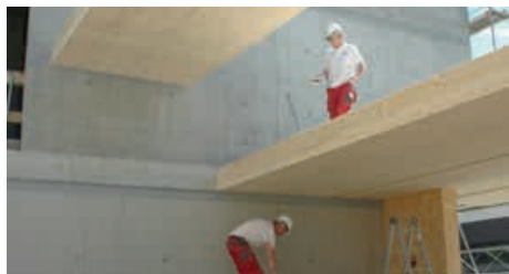
Dalles en caissons préfabriqués pour le Pavillon 5 d'Estavayer-le-Lac
